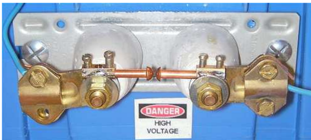
Рис. 3-0-16. Искровой промежуток из Kapagen (зазор от 0,9 мм до 1,2 мм).
